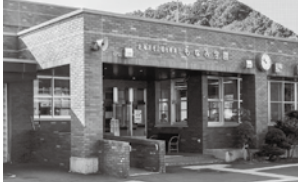
改築する旧もなみ学園施設
